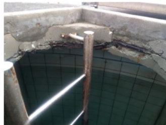
【圖 3-16】下層儲水池入口現況。
