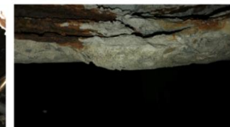
【圖 3-23】水塔夾層頂板蝕蝕狀況。
