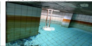
【圖 3-23】水塔夾層頂板蝕蝕狀況。
